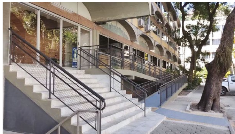
Figura 4.5 – Rampa de Acessibilidade ao prédio 02 da Faculdade de Administração e Ciências Contábeis
