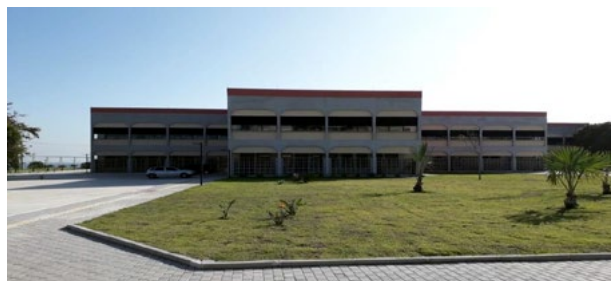
Figura 4.3 – Novos prédios do Instituto de Artes e Comunicação Social
