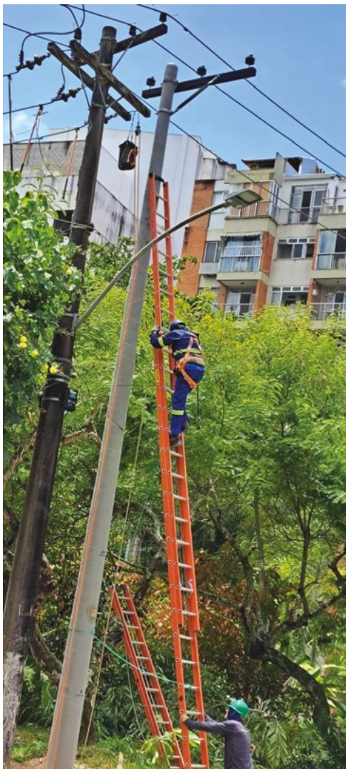
Figura 4.6 – Substituição de postes e cruzetas
