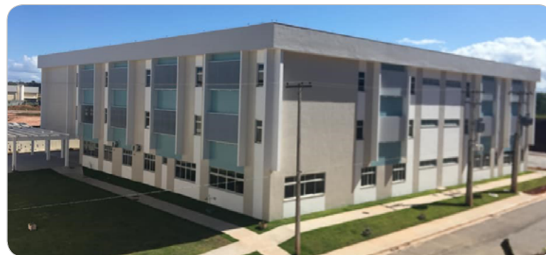
Figura 4.4 – Instituto de Ciências da Sociedade de Macaé
